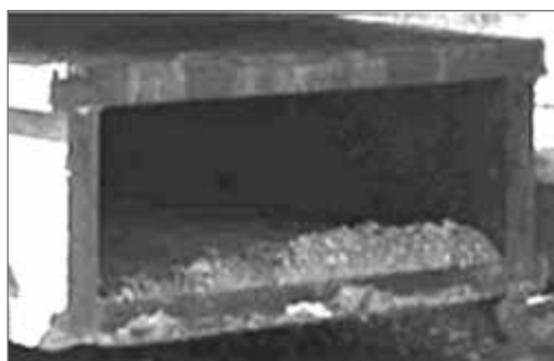
Am „Ground Zero“ geborgene Teile von Trägern aus dem Kern des WTC im Querschnitt. Jede Seitenwand misst gut sechs Zentimeter im Durchmesser. Diese dicken Stahlträger bildeten sowohl den Kern als auch den kompletten Rahmen der Zwillingtürme.
